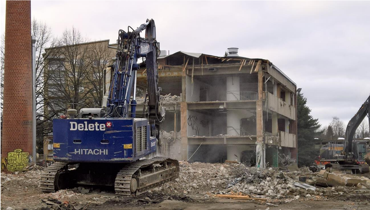
Tavanomainen purkukohde (koulu) ja vaativa purkukohde (vesitorni). Kuvat Markku Raimovaara
