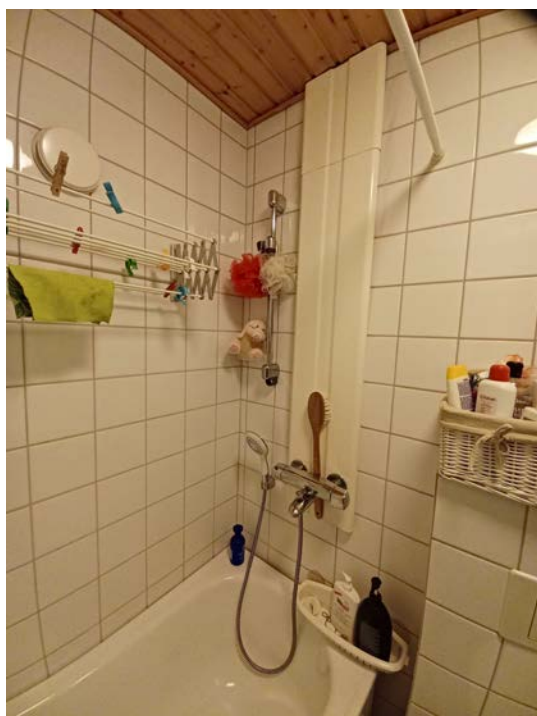
Kuva 10. Remontoitu kylpyhuone, jossa amme ja seinälle asennettu lämpimän käyttöveden verkkoon kytketty kuivauspatteri
