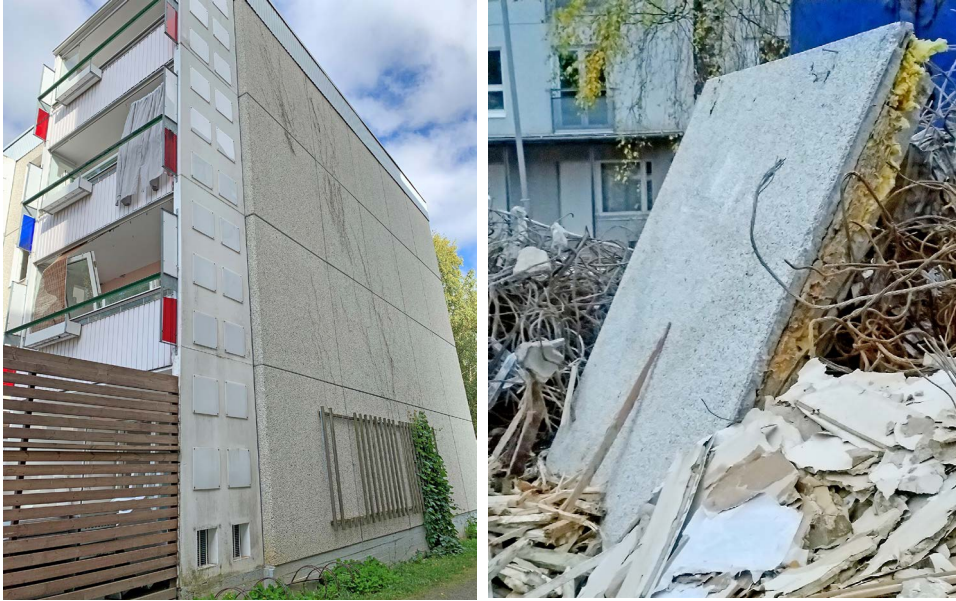
Kuvat 10 & 11. Elementti irrotettiin rakennuksen sivuseinän vasemmasta alalaidasta. Toisessa kuvassa irrotettu elementti muun rakennusjätteen seassa. (Kuvat Jenni Merjankari ja Markku Raimovaara)
