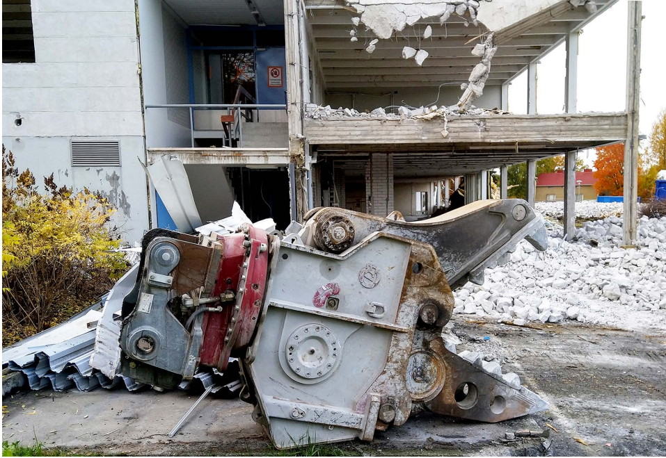
Kuva 3. Koulutuskuntayhtymä Tavastian purkukohde. Kuvassa etualalla pulverointileuka, joka on tärkeä työväline betonirakenteiden purussa. (Kuva Markku Raimovaara)
