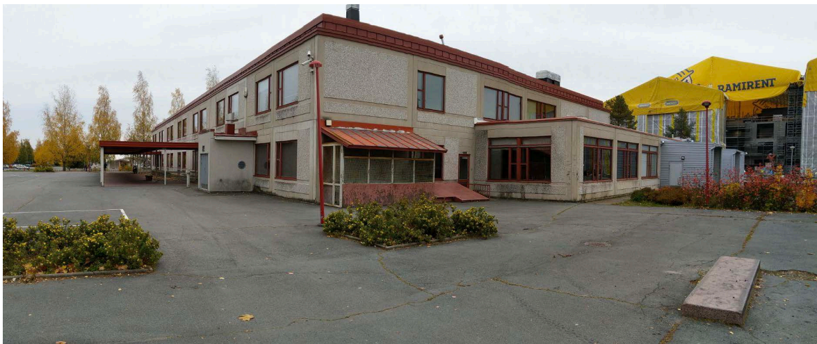
Kuva 5. Etualalla purettava Tölön koulu, takana oikealla rakenteilla oleva monitoimikeskus. (Kuva Markku Raimovaara)
