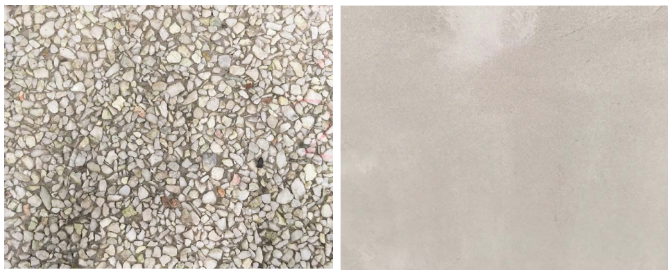
Kuva 15 & 16. Vasemmalla suoja-aineella käsitelty elementin pinta, oikealla kasvatettu suojabetonipeitettä. (Kuvat Arto Yli-Pentti)
