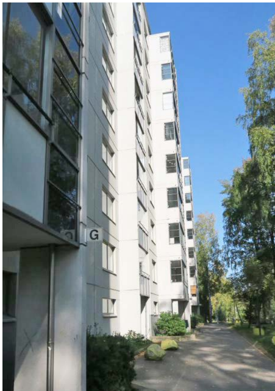
Kuva 8. Yleisnäkymä kohteesta ennen linjasaneerausta.
