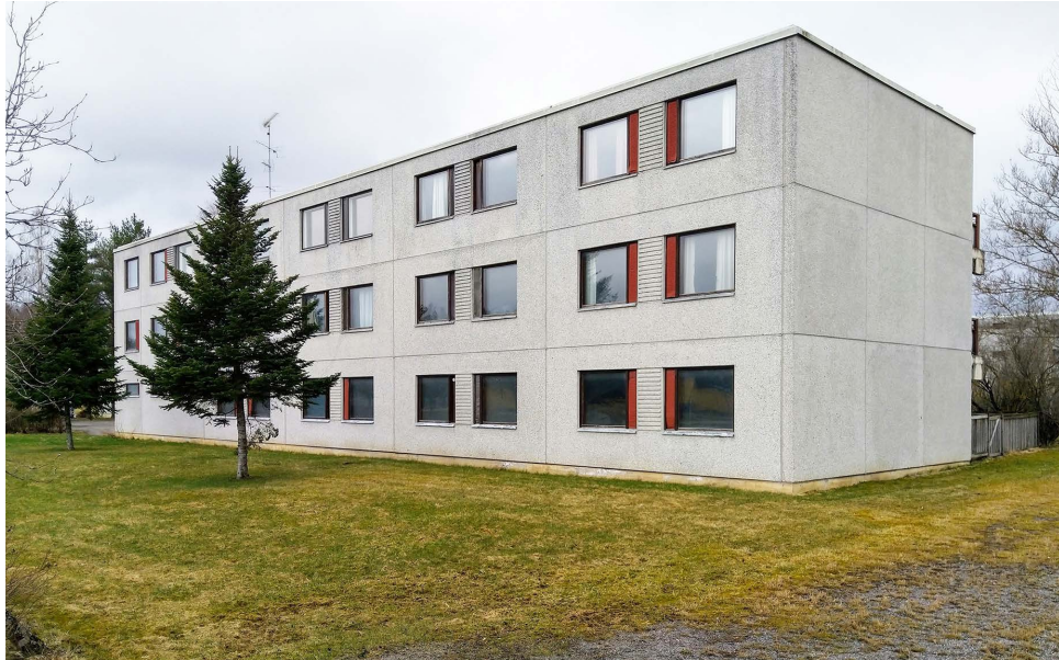
Kuva 7. Yleiskuva yhdestä Forssa-Asunnot Oy:n puretusta kerrostalosta. (Kuva Markku Raimovaara)
