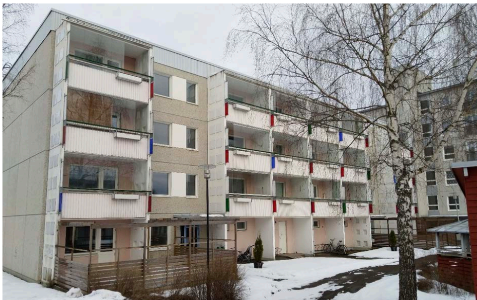
Kuva 6. Yleiskuva kohteesta Harakkamäki 5 CD ennen purkua. (Kuva Markku Raimovaara)
