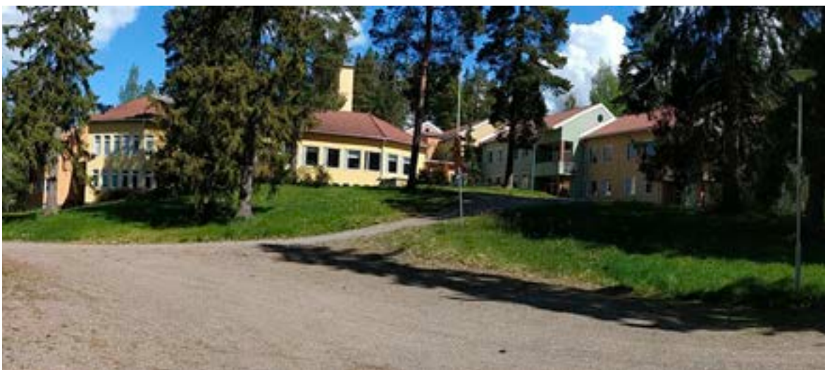
Kuva 4. Yleisnäkymä Vuorentaan vanhainkodista ennen purkua. (Kuva Markku Raimovaara)
